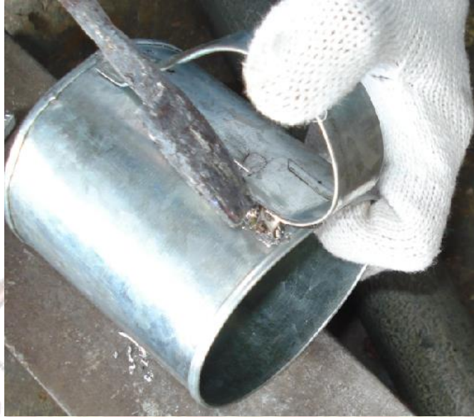
รูปที่ ๙.๑๔ แสดงการบัดกรีปลายของชิ้นงาน
