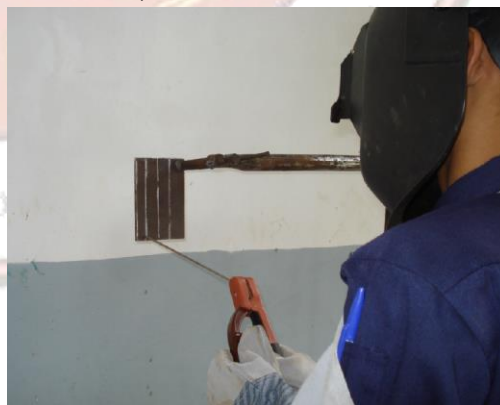
รูปที่ ๕.๔๖ แสดงตำแหน่งทำตั้ง (Vertical Position)
