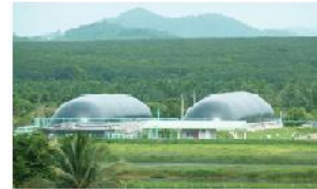
แก๊สชีวภาพ ( Biogas ) บริษัท ชุมพรอุตสาหกรรม น้ำมันปาล์ม จำกัด (มหาชน) หรือ CPI โดยนำมา ใช้ในการผลิตไอน้ำและกระแสไฟฟ้า
