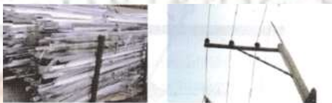
รูปที่ 6.6 การติดตั้งคอนแบบค้ำยัน
