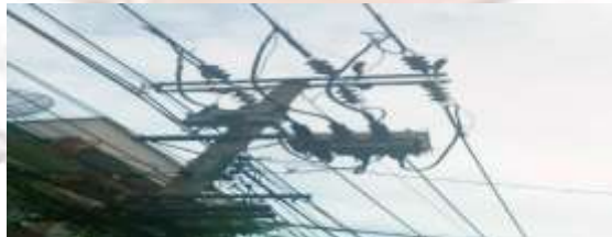
รูปที่ 6.2 การติดตั้งลูกถ้วยกับคอนคอนกรีต
