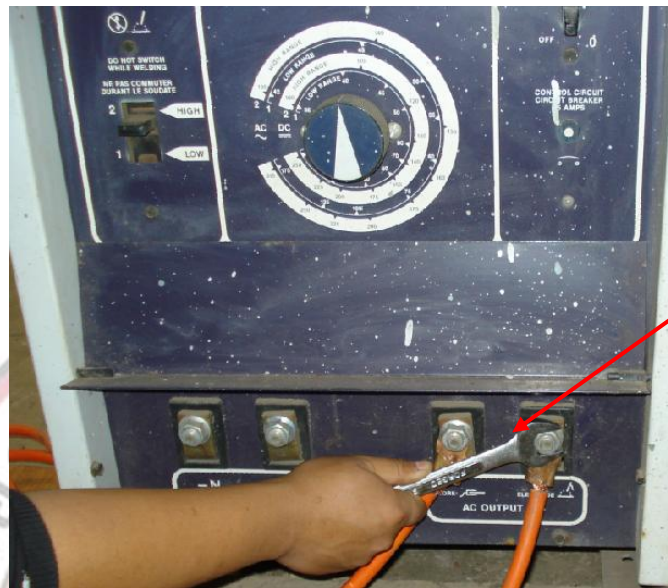
การขันขั้วต่อ สายเชื่อม
