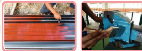
ภาพที่ 10.16 การทาสีกันสนิม ป้องกันการกัดกร่อน
