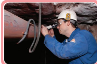
ภาพที่ 11.1 การตรวจสอบด้วยสายตา โดยมีเครื่องมืออุปกรณ์ช่วยในการตรวจสอบ
